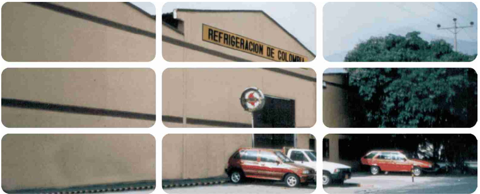
REFRIDCOL Instalaciones en Acopi, Yumbo - Colombia
